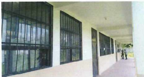
Foto1: Aulas con balcones primer nivel, Básico
