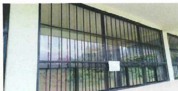
Foto 2: Aulas con balcones, Básico.
