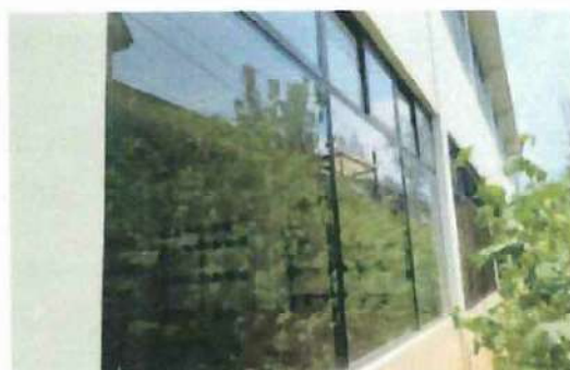
Foto 8: Aulas sin y con balcones parate de atras primer nivel, Básico.
