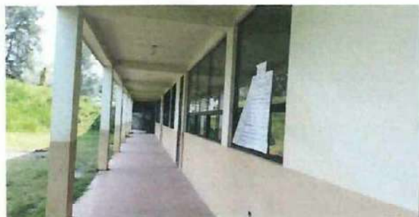
Foto 4: Pasillo primer nivel aulas con balcones y sin balcones, Básico.
